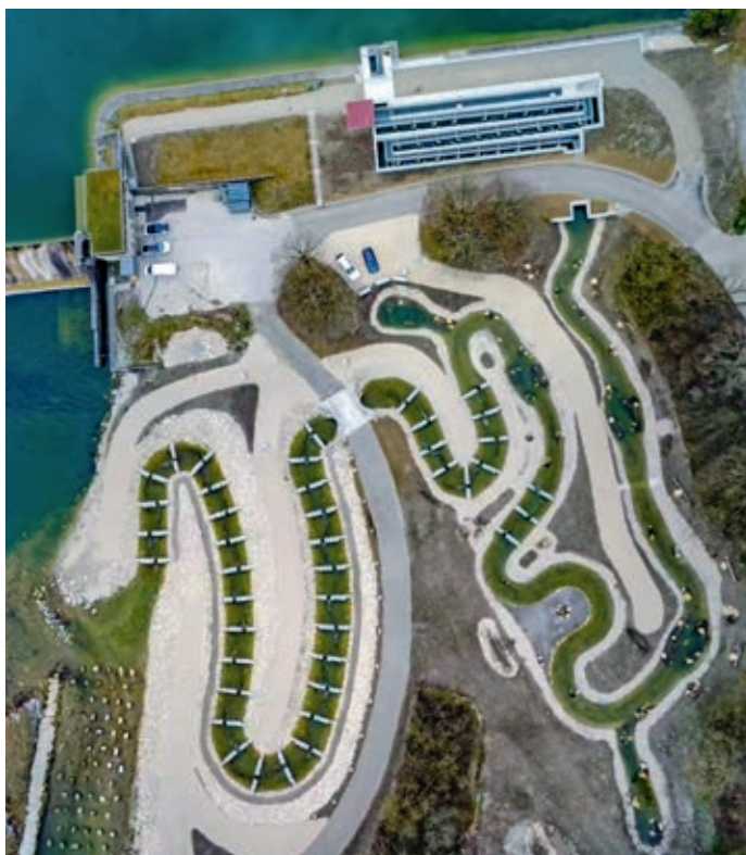
Luftaufnahme Fischaufstiegshilfe in Epfach
